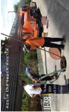
การสูบลบตะกอนระบบบำบัดน้ำเสีย
